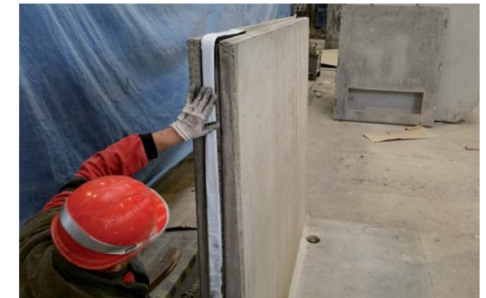
4 / Butylkaučuk se přilepí tak, aby přesahoval do horní vodorovné drážky cca 0,5 m.
