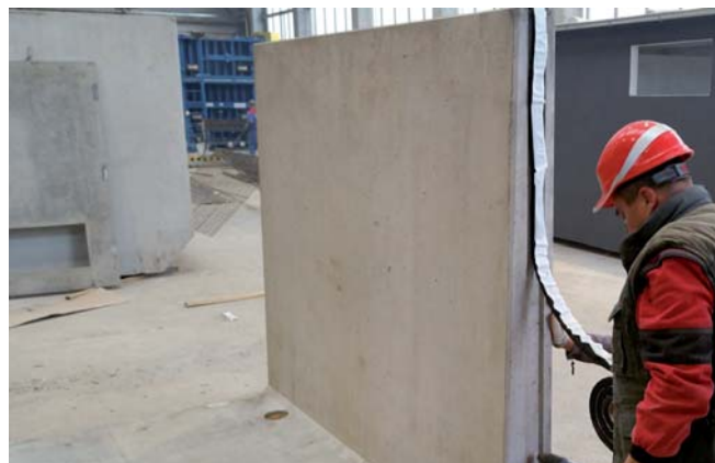
2 / Do drážky se vlepí pásek z butylkaučuku.
