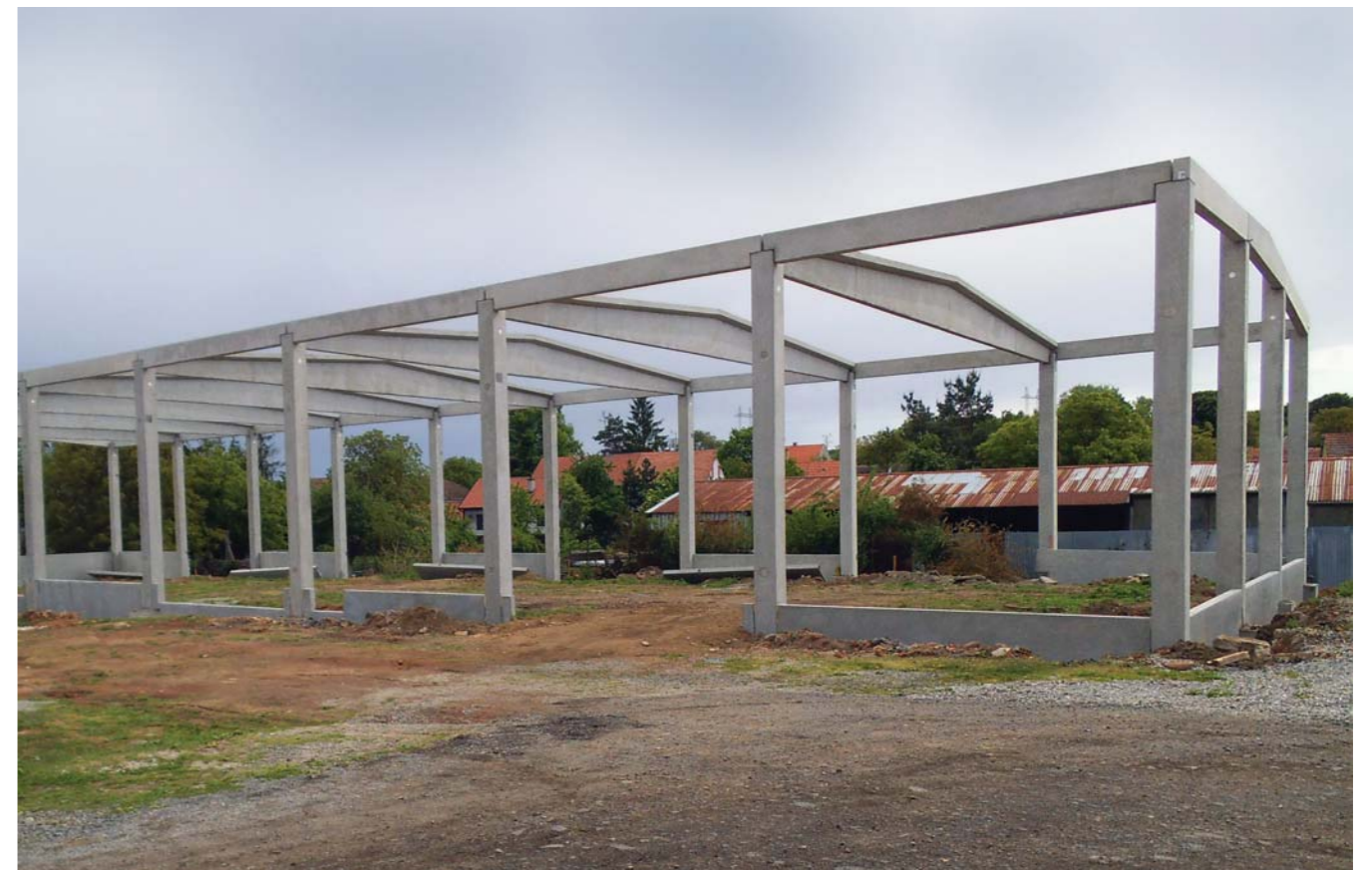
Železobetonová hala – Avanta Brno
