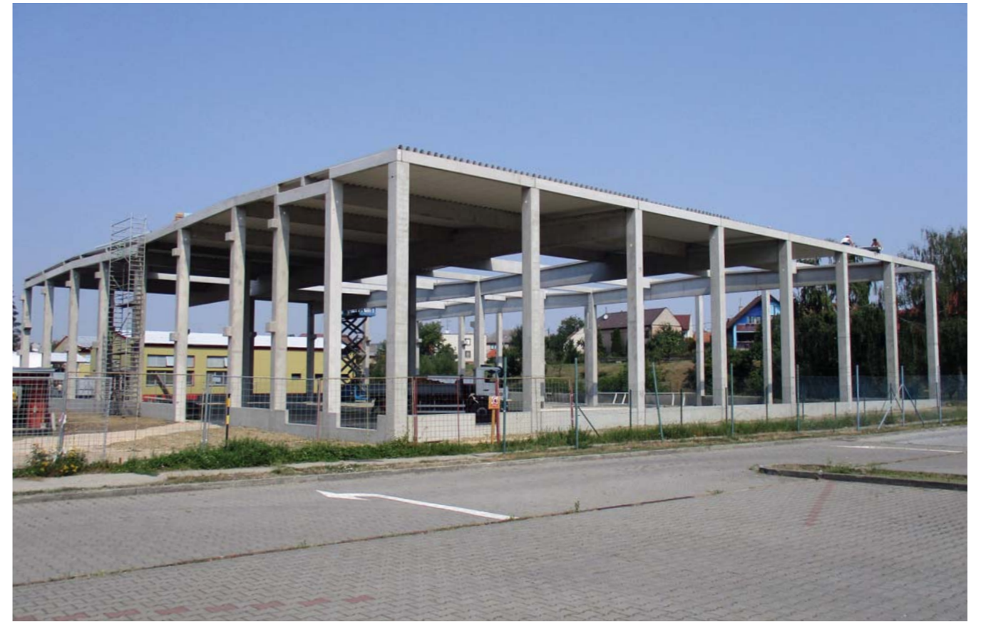
Železobetonový skelet – Kovoplát Hluk
