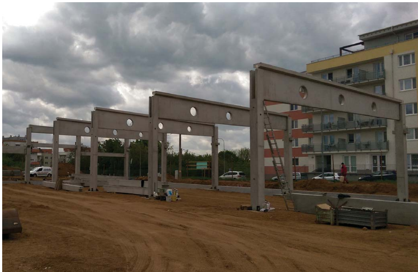
Železobetonový skelet – Albert Kamechy Brno
