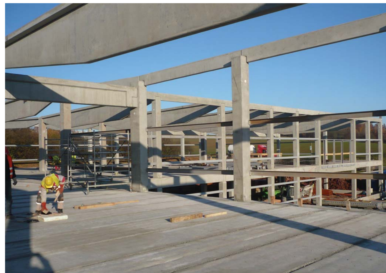
Výstavba haly – Úpice
