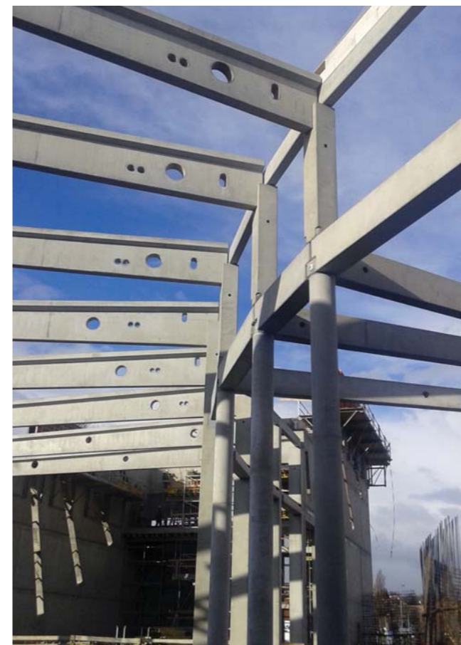
Železobetonový skelet – Herní centrum, Brno
