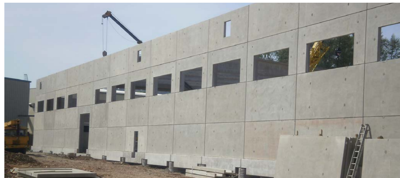
Čelní pohled na halu pro firmu JUTA a.s. – Úpice
