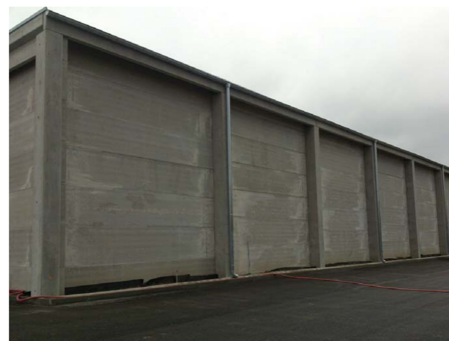
Výstavba pláště výrobní haly bioplynové stanice ve Žďáru nad Sázavou
