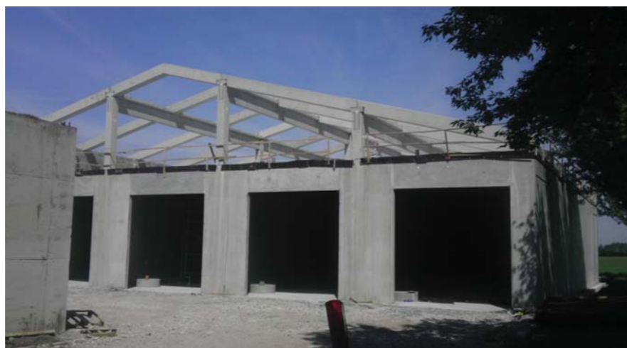
Výstavba bioplynové stanice Hořátek
