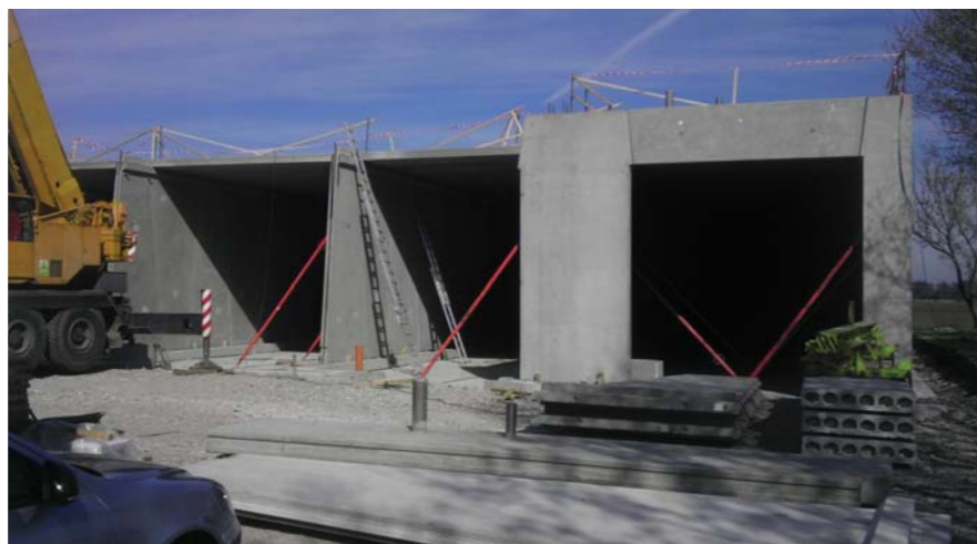
Výstavba bioplynové stanice Hořátek
