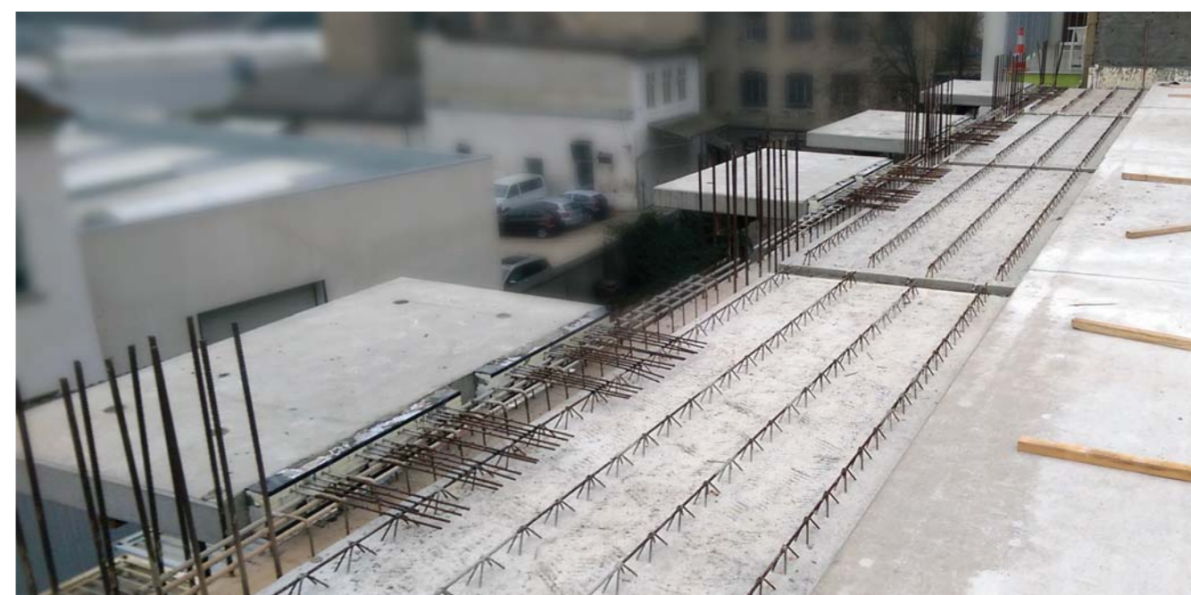
Výstavba bytových domů – Brno
