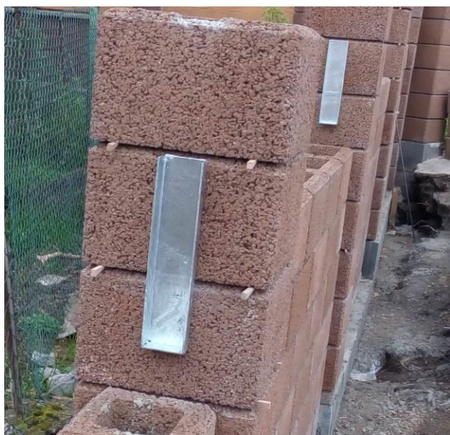
Obrázek 4 – Vložení ocelového držáku plotové desky a dřevěných klímků pro vyrovnání tvarovek do roviny
