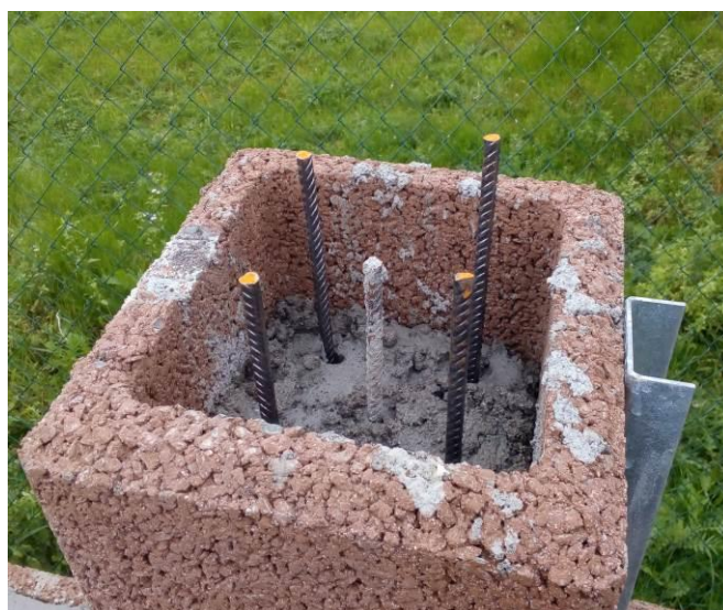
Obrázek 6 – Vložení svislé výztuže
