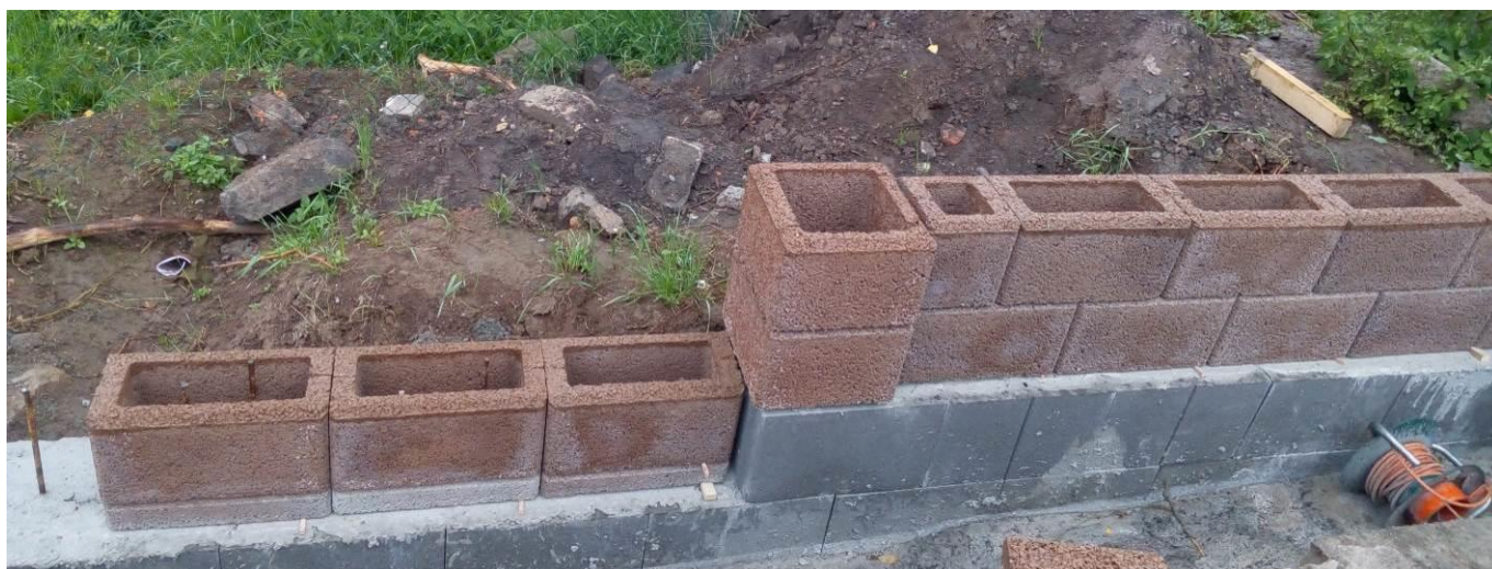
Obrázek 3 – Založení stavby plotu
