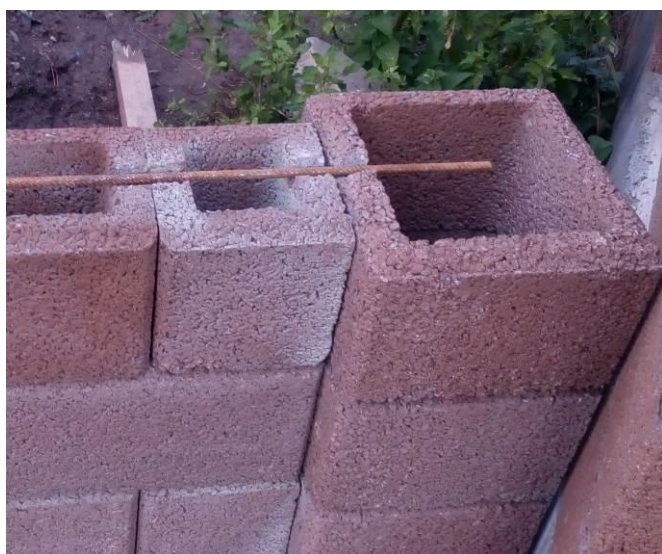
Obrázek 5 – Vložení vodorovné výztuže
